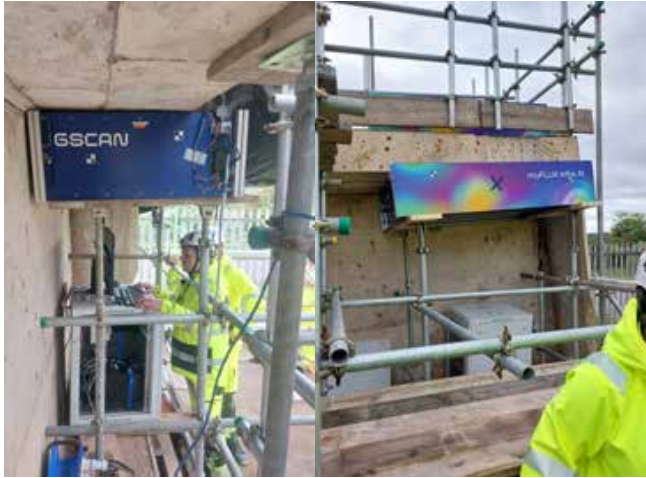
Järelpingestatud raudbetoonist silla elemendi läbivalgustamine Suurbritannia uurimisprojekti "Structures Moonshot" raames. September 2023.
