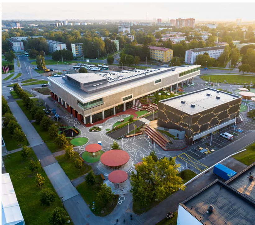
Mustamäe riigigümnaasium valmis betoonist ja terasest, puitu kasutati vaid dekoratiiv- või fassaadimaterjalina.
