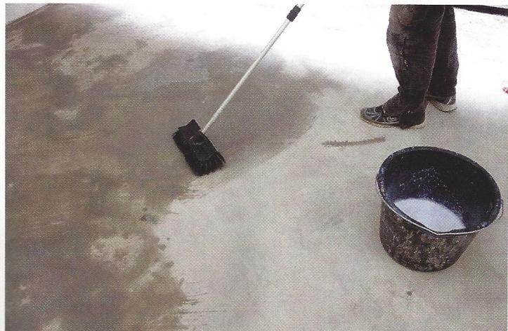
KRUNTVÄRV hõörutakse aluspõrandale harjaga. Eesmärk on betoonpõrand üleni hoolikalt alusvärviga katta, et betooni poorid ei jäeks avatuks. Põhjalik kruntimine on järgnevate töötappide õnnestumise eelduseks.
