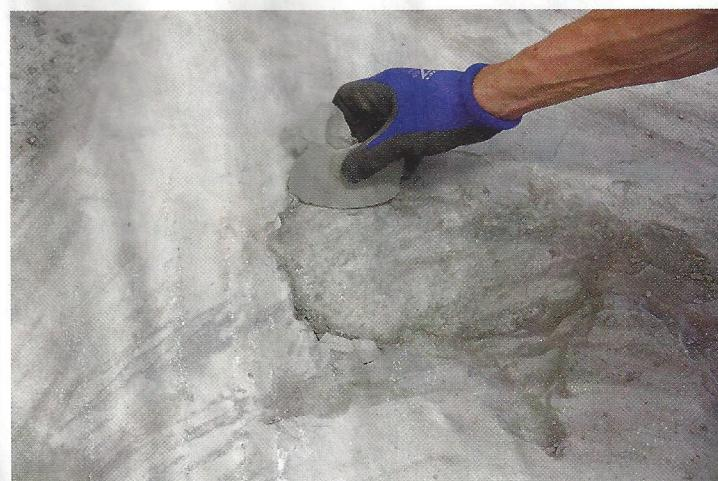
↑ PÕRANDATASANDUSSEGU ei nakku korralikult aluspõrandaga; kui aluspõrandalt jääti tsemendiliim eemaldamata; kui tasandussegu survetugevus ei vasta põranda koormusele; kui betoonpõrand on liiga niiske (üle 90% RH) või eeltöötlus jäi üldse tegemata.
