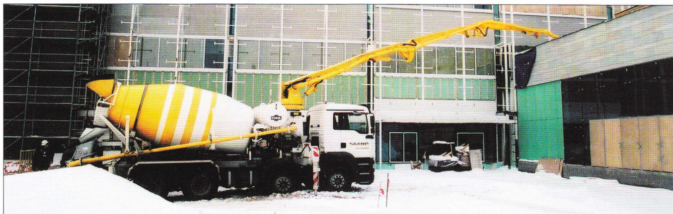
Segurautoga betoonipump tööasendis.
