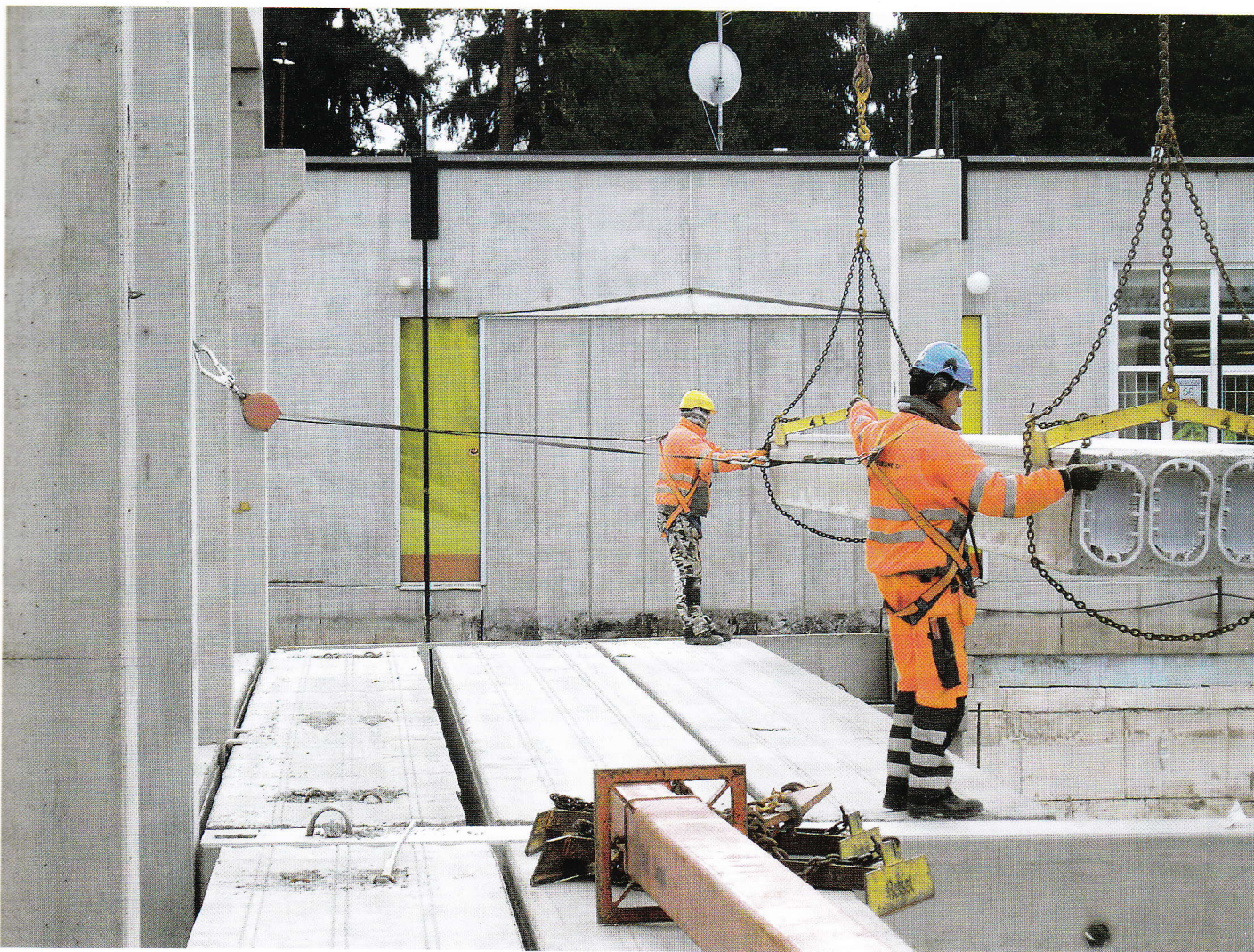
5 Asennustyön työturvallisuudesta on laadittu useampia ohjeita. Kuvassa asentajan turvaköysi on kiinnitetty tehtaalla pilarin kylkeen valettuun vajjerilenkkiin.
