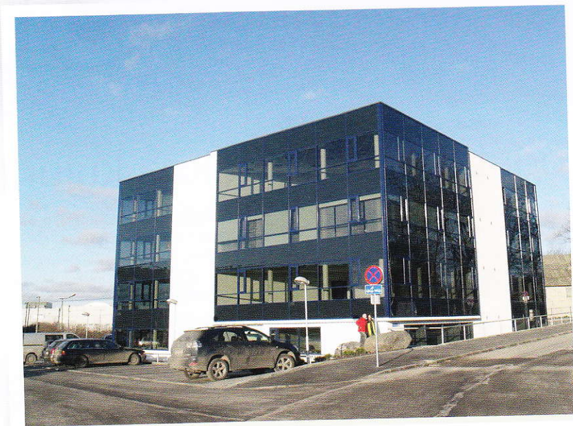
ESIMENE MITMEKORDNE KIUDBETONIST VUNDAMENDI JA VAHELAGEDEGA BÜROOHODNE TALLINNAS, KOTKAPOJA TÄNAVAL.
