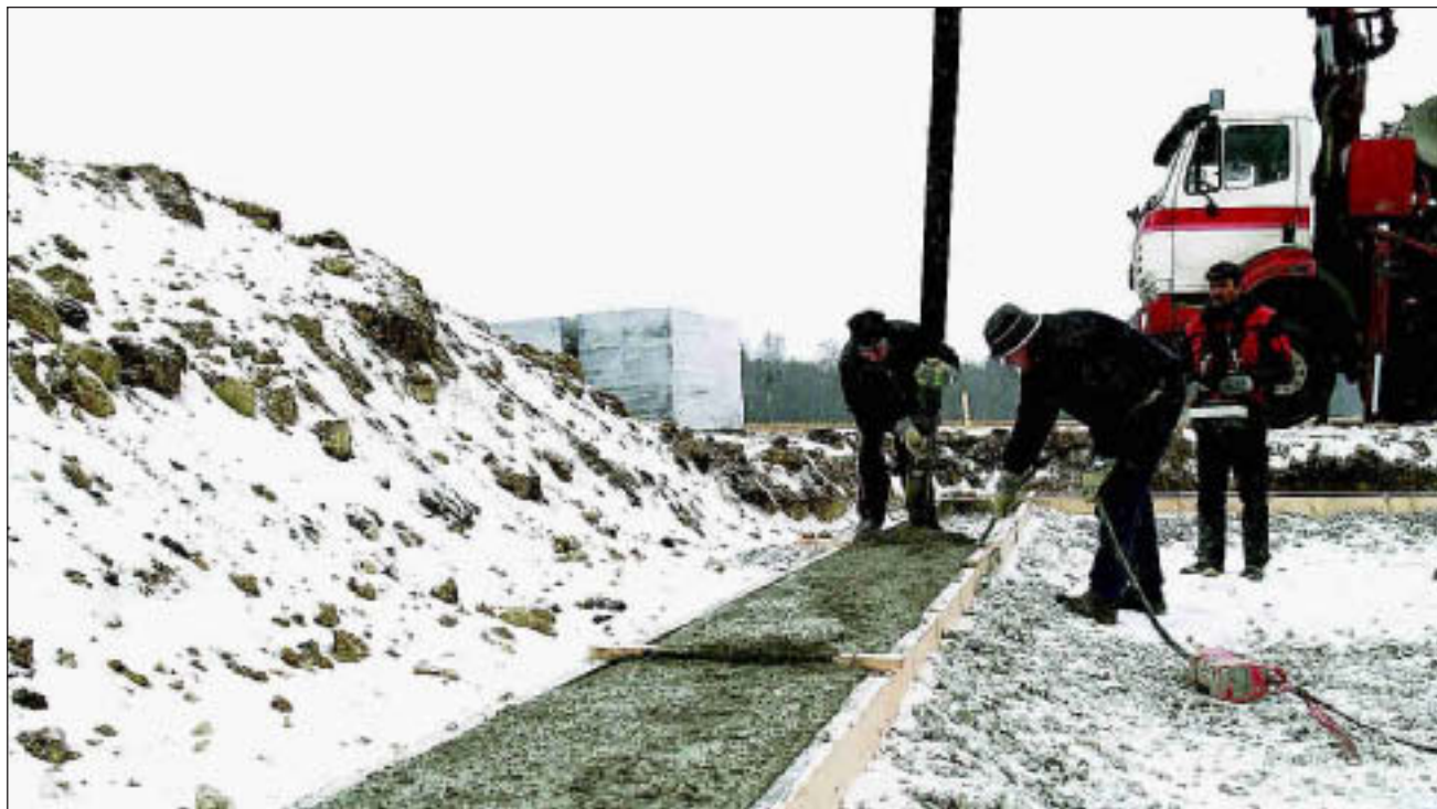
Talvistel betoonitöödel on efektiivne kasutada kõrgemargilisi (> C28/35) betooni.
