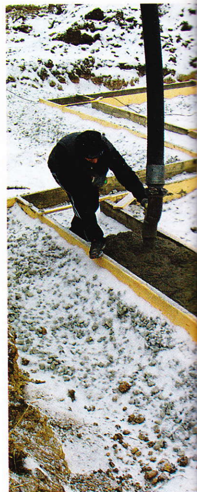
Betooni tasandamine (lattimine). Talvel välitingimustes tuleks vältida betoonipinna lihvimist.
