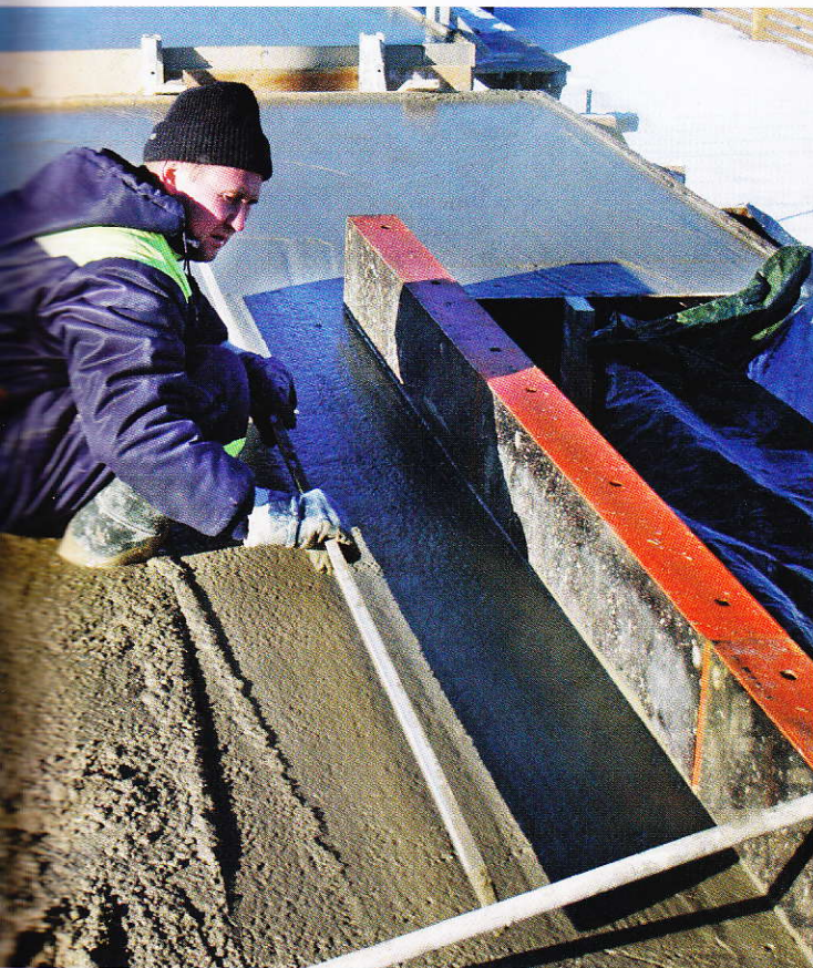
Betooni pumpamine on üldjuhul võimalik kuni õhutemperatuurini -10^{\circ}\text{C} .
