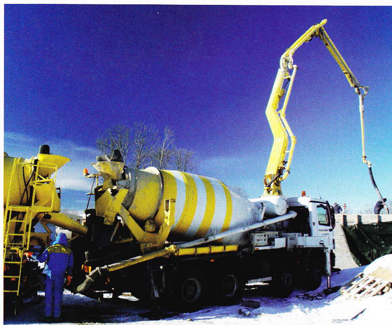
Betooni pumpamine on üldjuhul võimalik kuni õhutemperatuurini -10^{\circ}\text{C} .
