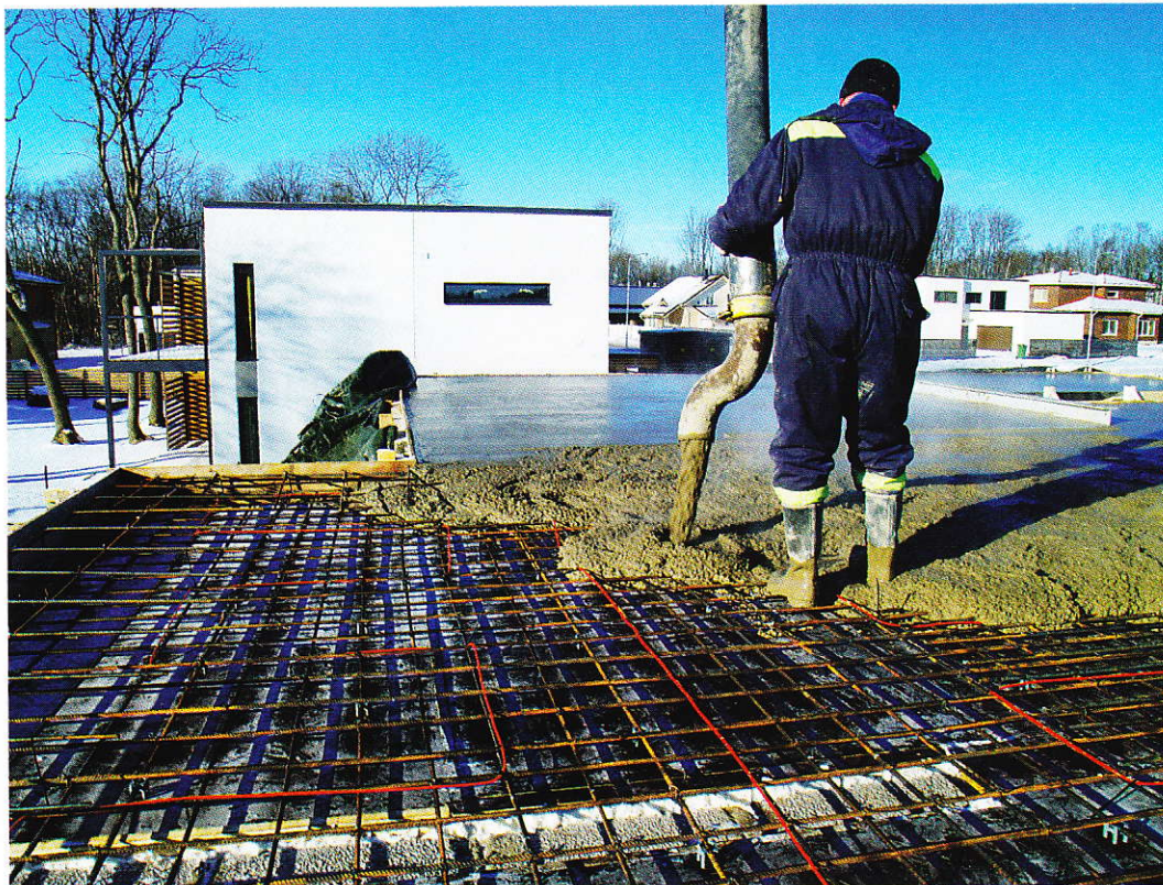
Eramu vahelae betooni paigaldamine. Valu soojendamiseks võib kasutada muuhulgas kütetraate.
