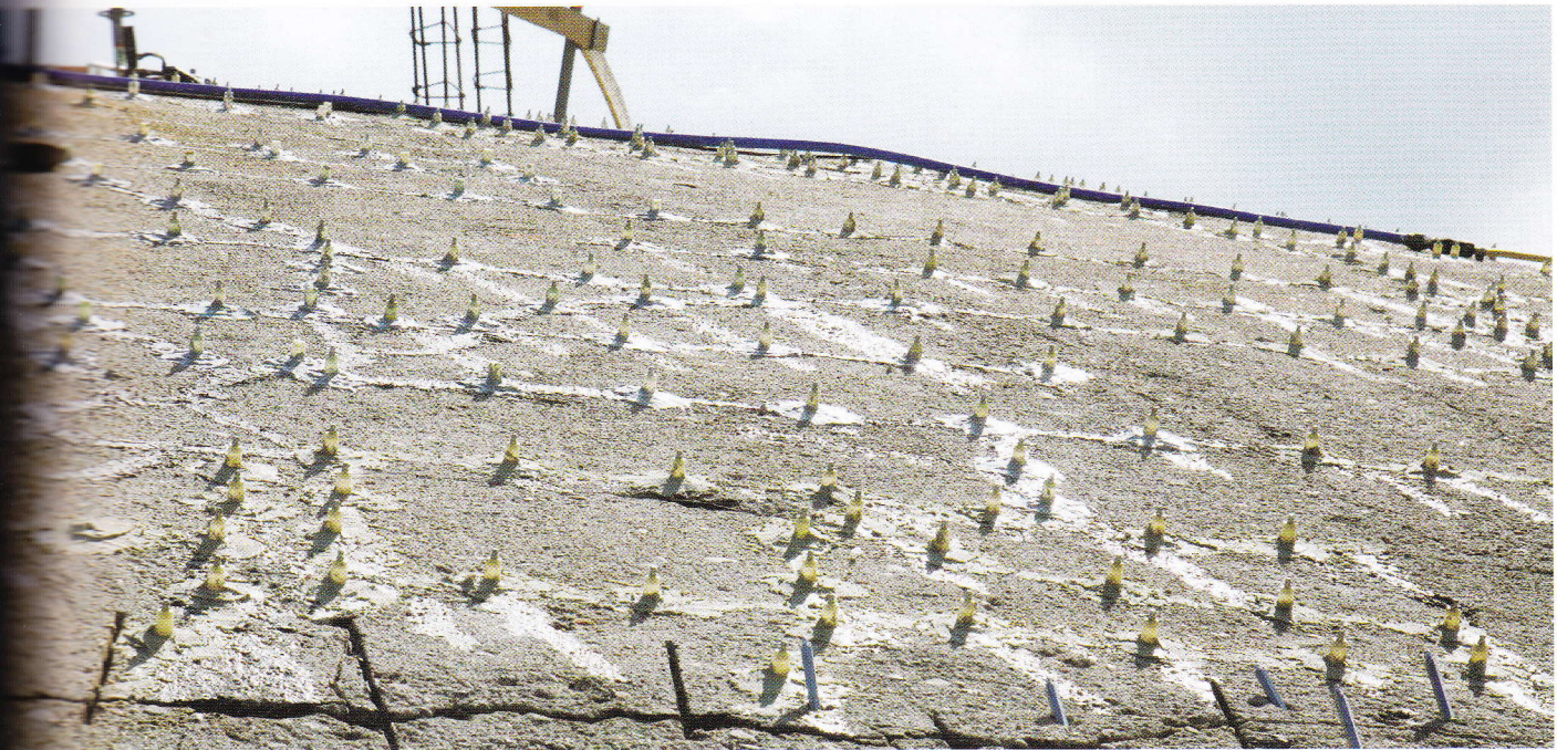
Päckerite ehk omalaadsete ventiilide kaudu pumbatakse betoonkonstruktsiooni sisse injekeerimise segu.
