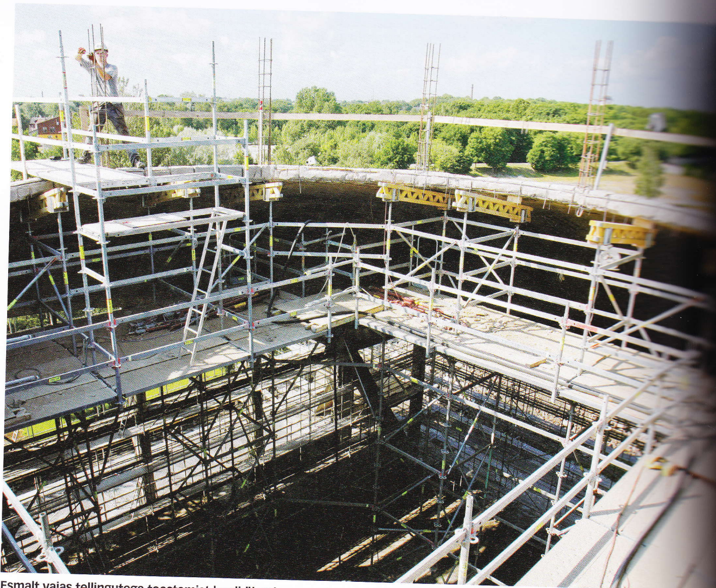
Esmalt vajas tellingutega toestamist kupli ülemine serv. 160 tonni tellinguid paigaldati 10 inimesega 15 päeva.
