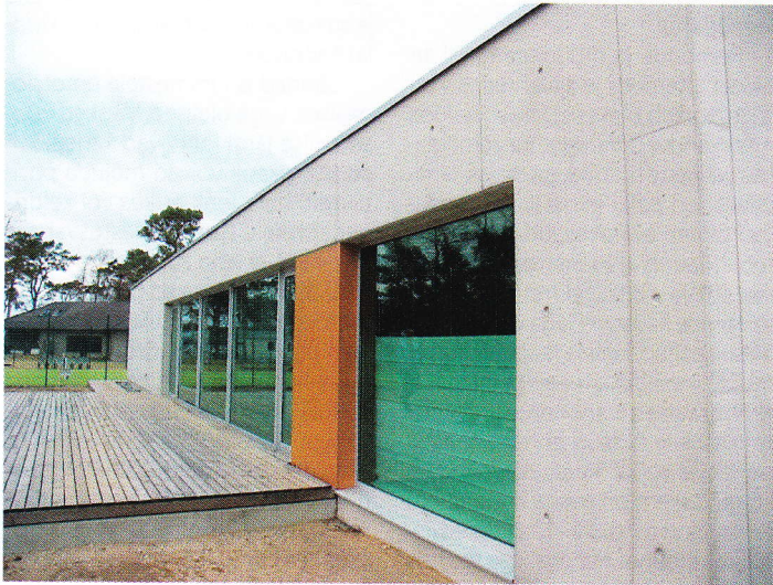
AS Peri abil valminud betoonaed (detail) ja eramu.
