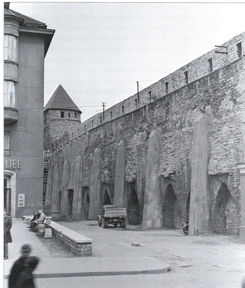
Ehedalt eksponeeritud betoonist toed ajaloolisel linnamüüril 1960. aastate algusest on modernistliku restaureerimise heaks näiteks. Karl Orase foto (1961), Eesti Filmiarhiiv.
