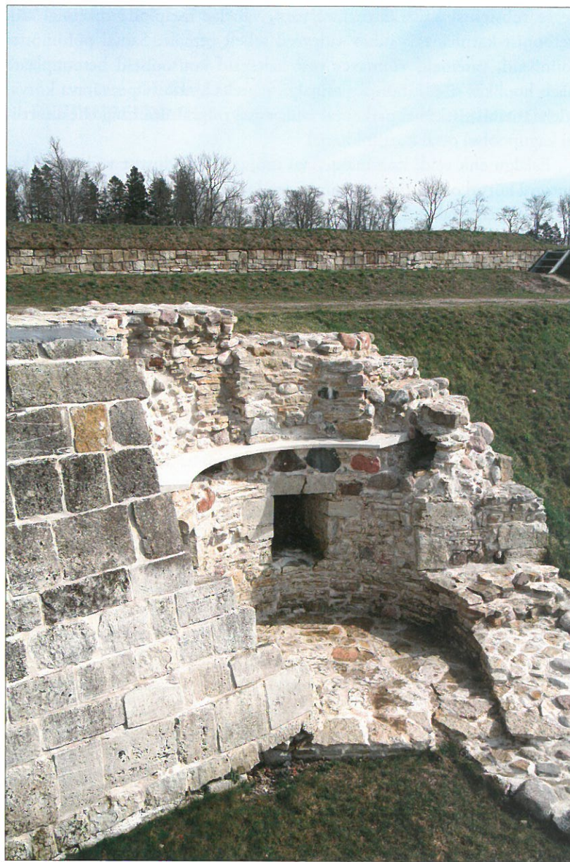
Konserveeritud Idatorn betoonist karniisiga. Tõnu Sepa foto, 2015.
