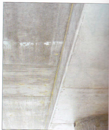
Lae vasak pool on valatud kolmekihilise valuplaadiga, parem PERI Betoga.
