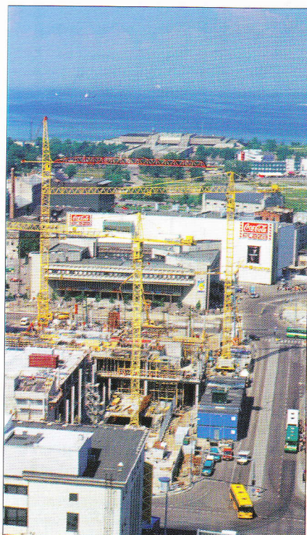
Viru keskuse betoonitöödel kasutati PERI raketisi.
