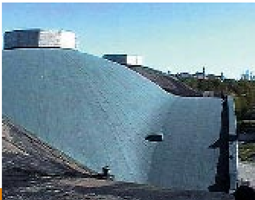
Katusekatte paigaldamine. Angaaripaigaldatud katusekattega.
