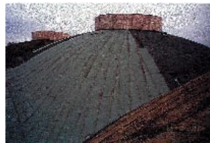
Katusekatte paigaldamine. Angaaripaigaldatud katusekattega.
